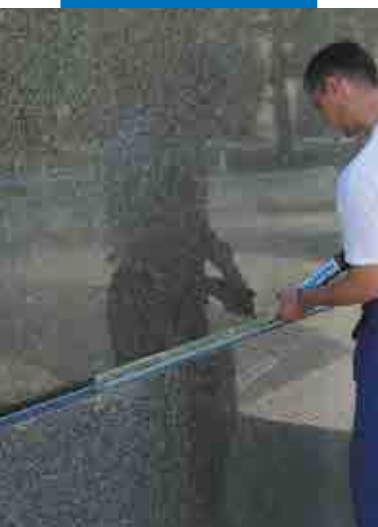
Fogning av fasad med Mapesil LM
